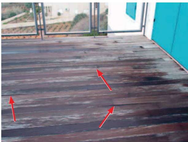
Slike 1a i b. Pogled na terasu (lijevo) i vrta (desno). Mjestimične duge reške nastaju bubrenjem obložne plohe po cijeloj širini poda, prekomjernim bočnim tlakom i izdizanjem pojedinih dasaka (strelice).
