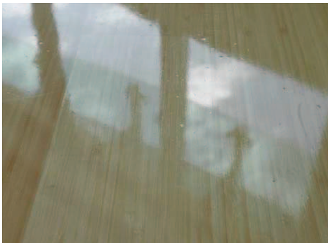
Slika 2. Mjehurići u gornjem sloju filma laka vidljivi su ravnomjerno raspoređeni po dijelovima podne plohe
