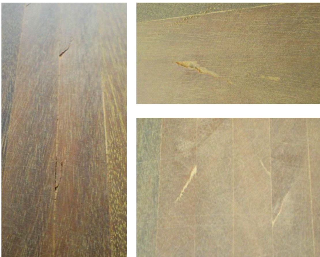
Slika 7. drvo vrste ipe-lapacho pokazuju radijalne pukotine koje su nastale kod sušenja, otvaraju se pri brušenju parketa. Nakon završne obrade, naglo isušivanje lica parketa dovodi do razlistavanja i odizanja iverja (lijevo)
