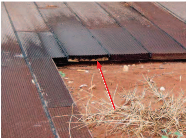
Slika 4. Detalj oplošja vrtno terase pokazuje nastavno spajanje prekratkih komada i zarazu gljivama u kontaktu s tlom (strelica).
