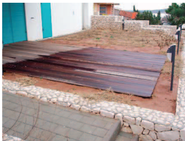
Slike 1a i b. Pogled na terasu (lijevo) i vrta (desno). Mjestimične duge reške nastaju bubrenjem obložne plohe po cijeloj širini poda, prekomjernim bočnim tlakom i izdizanjem pojedinih dasaka (strelice).
