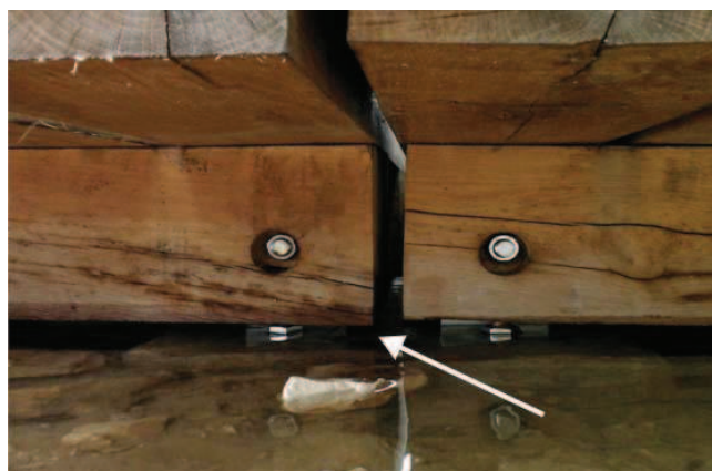
Slika 3. Podnožje staze. Površina drva je prosuha, čela su pravilno razmaknuta ali upijaju zapljusnutu vodu u smjeru pukotina skošene žice (strelica).
