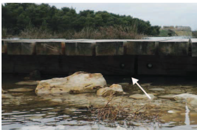
Slika 2. Hodna ravnina malo deformirana, bridovi izdignuti. More oplahuje drvo za plime (strelica)
