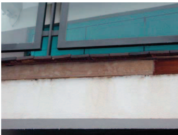
Slika 3 a i b: Čeonu rub oplošja terase :Lijevo (slika ) se vidi da se daske koritave bridovima prema gore a podgled zatvara ventilaciju podstloja. Desno se vidi uspješno sanirano stanje.
