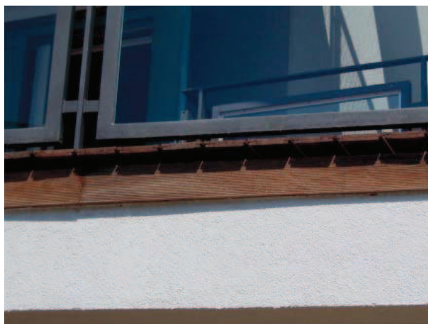
Slika 3 a i b: Čeonu rub oplošja terase :Lijevo (slika ) se vidi da se daske koritave bridovima prema gore a podgled zatvara ventilaciju podstloja. Desno se vidi uspješno sanirano stanje.
