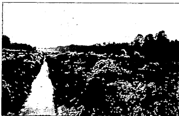
Sl. — Abb. 7. Jaki vodotehnički zahvati u arealu nizinskih šuma. Dubok kanal koji uvjetuje promjene razina podzemnih voda. Prilikom izgradnje kanala iskrčren je širok pojas šume. Srednja Posavina. — Starke wassertechnische Eingriffe im Areal der Auenwälder. Tiefer Graben, welcher Veränderungen des Grundwasserniveaus hervorruft. Für den Graben wurde ein breiter Waldstreifen geräumt. Mittlere Savaebene.
